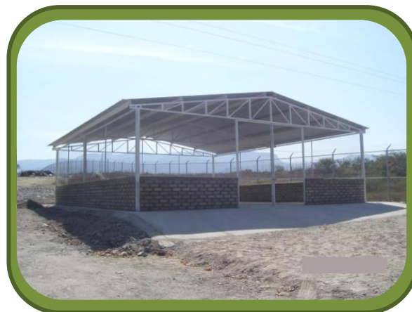
Centro de Acopio Temporal de Envases Vacíos de Agroquímicos ubicado por el Camino al Aguacate
